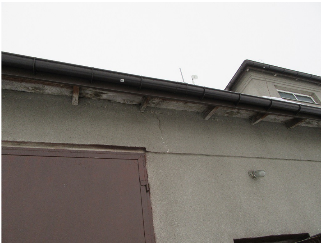
Zarysowania powstałe w wyniku niedostatecznego przekroju elementów nadprożowych. Do naprawy.
